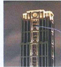
一品苑大樓基礎主結構體
